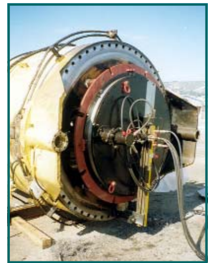
Flanscbearbeitung einer Zahnkranzauflage Machining a slewing-ring flange on a crane house
