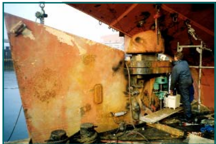
Ruderflansche fräsen und bohren der Passbolzenbohrungen Milling rudder flanges and machining the fitting bolts borings
